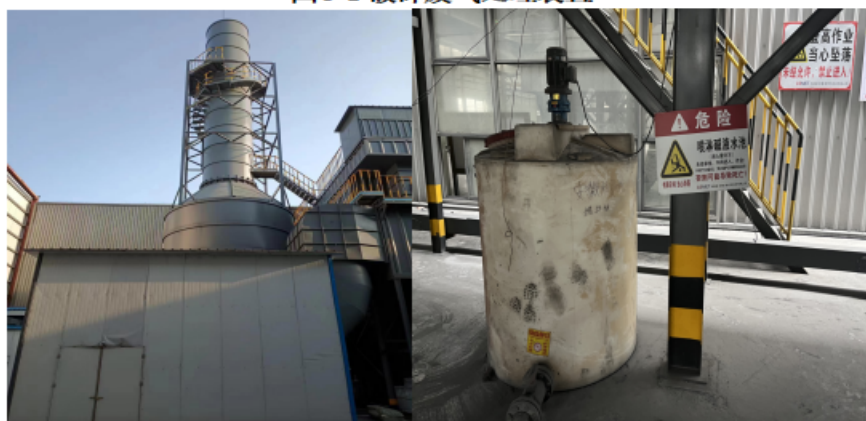
图3-1 破碎废气处理装置
