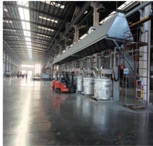
图 3-3 烤包废气处理装置
