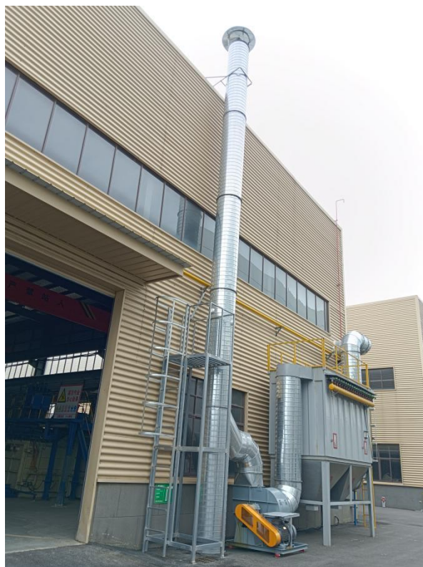
图4-4 熔炼废气排放口（DA001）
