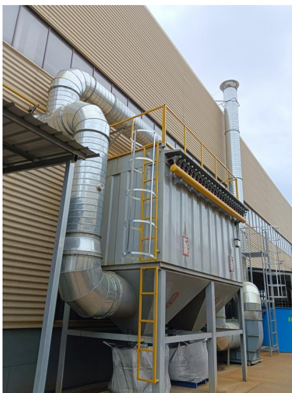
图4-6 抛丸、打磨、焊补废气排放口（DA004）
