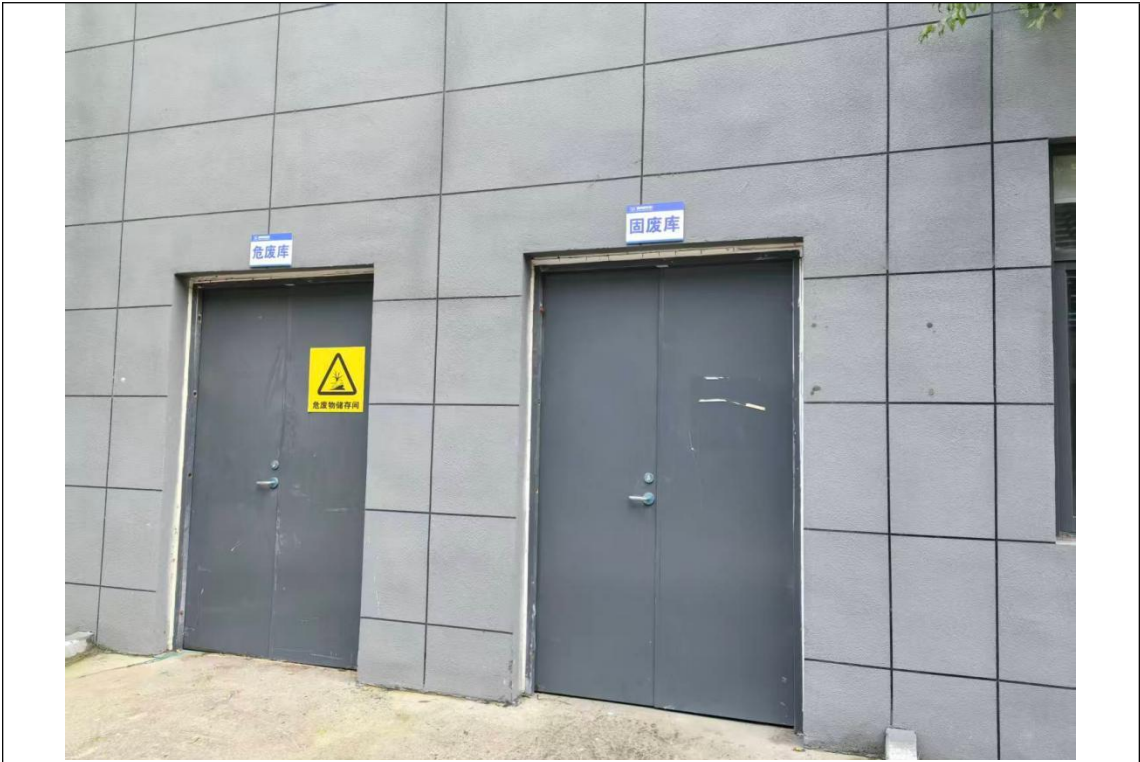
图 4-12 危废库和固废库照片
