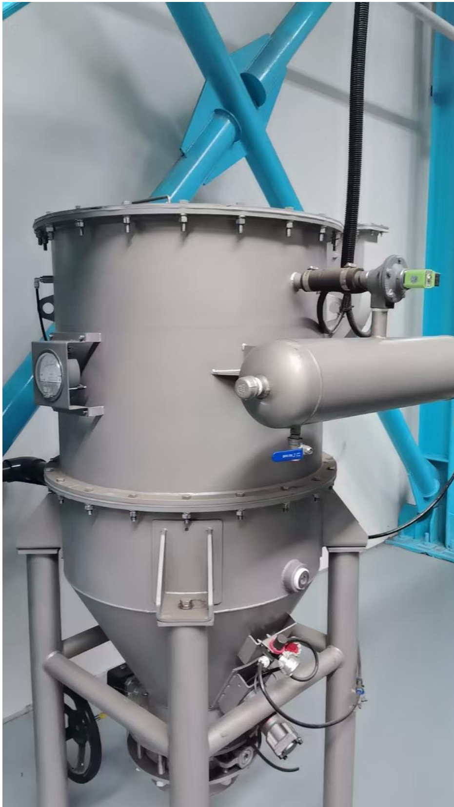
图4-10 层氧正极材料包装工序布袋除尘器
